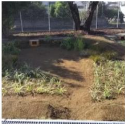
0017 透水性保水型改良土 (トース土) を用いた雨庭
