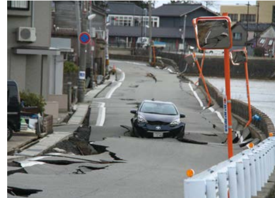
石川県輪島市
