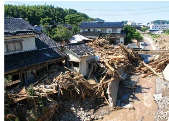
石川県輪島市
