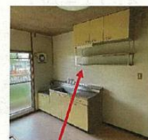
④ 吊戸棚の位置が× フードがない
