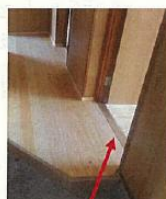
① 既存の敷居
