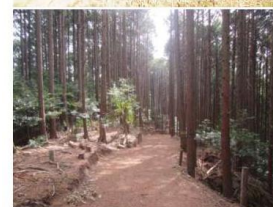
整備する森林へ向かうための路網の整備を実施。
