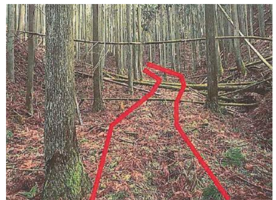
森林作業道整備前の状況 (伊賀市布引地域)
