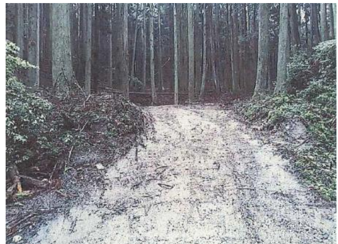
森林作業道整備後の状況(伊賀市布引地域)
