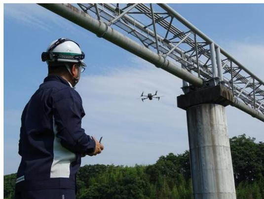
ドローンによる水管橋点検状況
