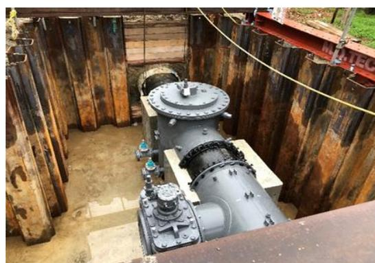
不断水工法<sup>※</sup>による制水弁設置状況
