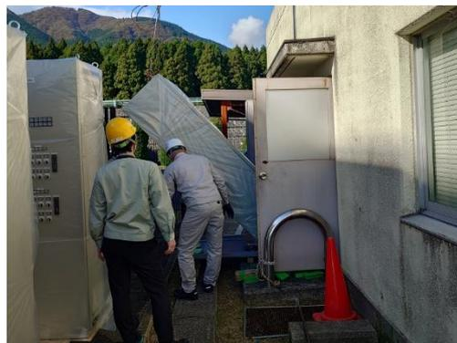
更新工事中の水沢浄水場ろ過池制御設備
