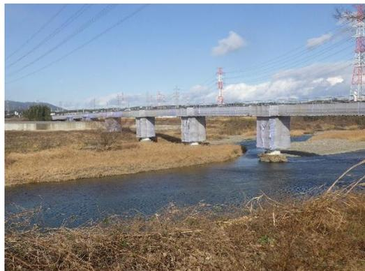
塗り替え工事中の員弁川水管橋
