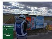
現場代理人が現地をWeb配信
