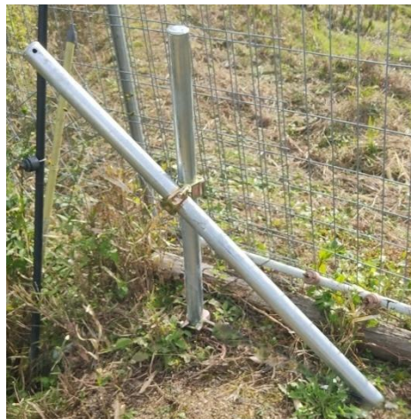
図3 始点用支柱の設置状況
