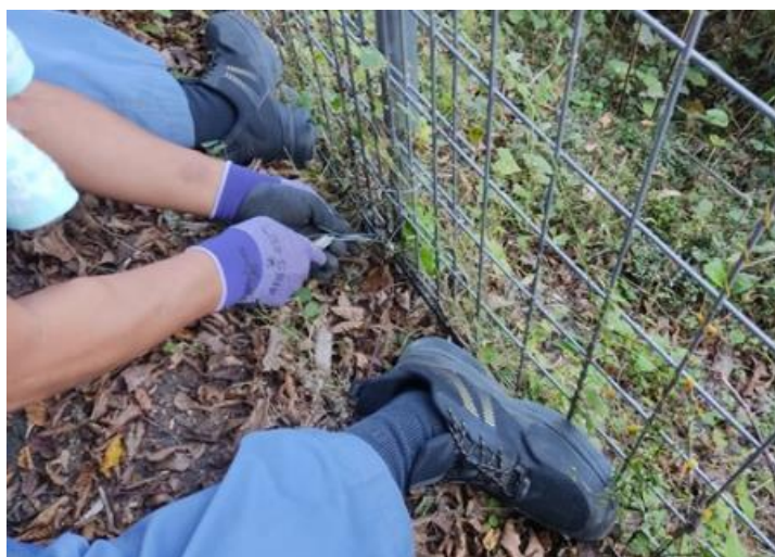
図 12 足で樹脂ワイヤーとワイヤーメッシュパネルを密着させた状態で、ハッカーを使い強固に結束する
