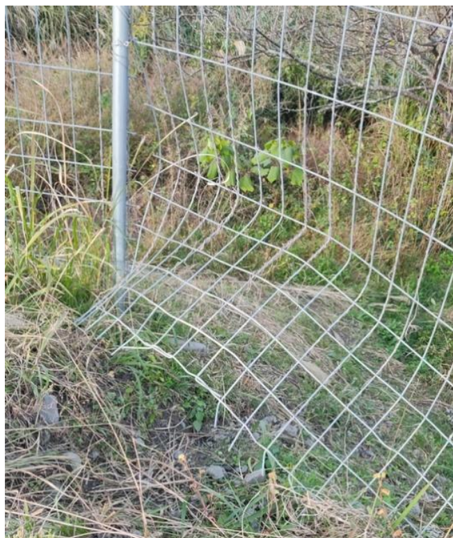
図1 イノシシに押し上げられて 損傷したワイヤーメッシュ柵
