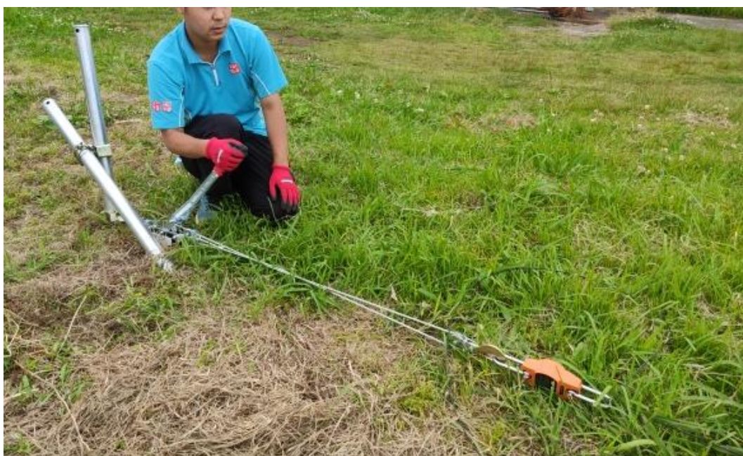
図 10 張力計(クレーンスケール)の値を確認しながら、ハンドウインチを使用して、樹脂ワイヤーに100kgfの張力を持たせる
