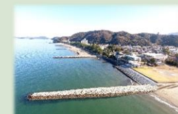
宇治山田港海岸 高潮・侵食対策事業（伊勢市）
