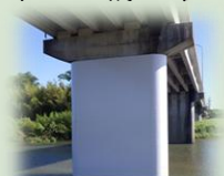
橋梁の落橋・倒壊対策
