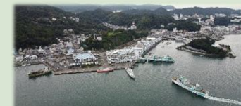
鳥羽港 耐震強化岸壁の改修（鳥羽市）
