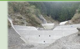
治山ダム（松阪市）
