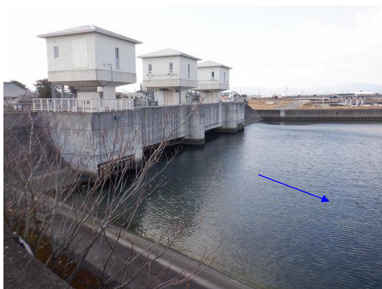
百々川 防潮水門
