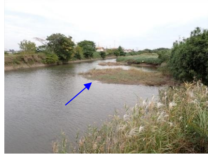
三渡川 岩内川合流点下流 (中流部)
