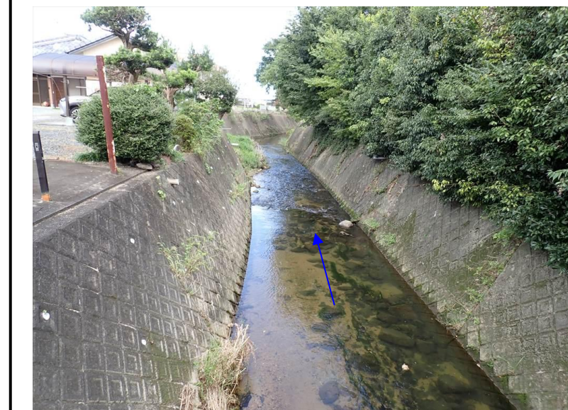
上流端から下流方向
