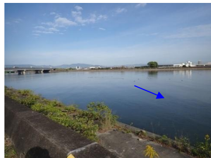
三渡川 三渡大橋下流 (下流部)
