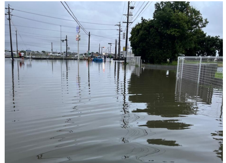
【令和6年台風10号 内水・外水被害】 （百々川：松ヶ島町地内・市道長泉寺線）
