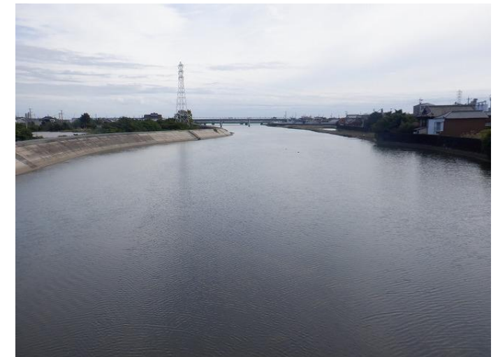
三渡川下流部の様子 (市道三渡橋より下流写す)
