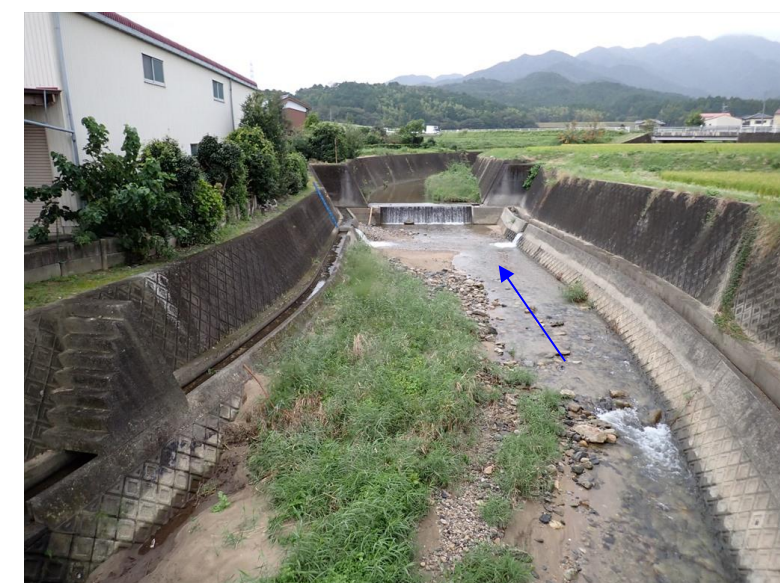
上流端から下流方向
