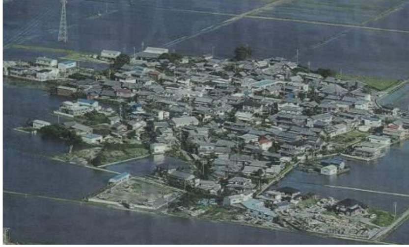
【平成16年台風21号 内水被害】 （三渡川：津屋城地内）
