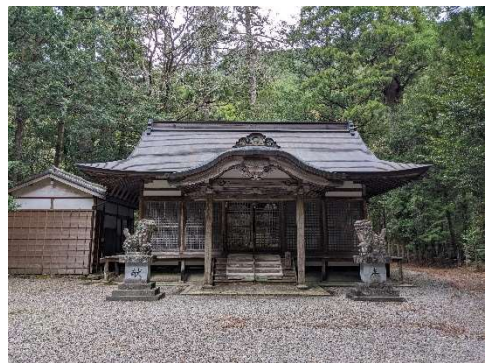
図 29 八柱神社本殿
