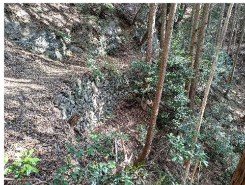
図 117 三浦峠道 野面乱積みの石垣
