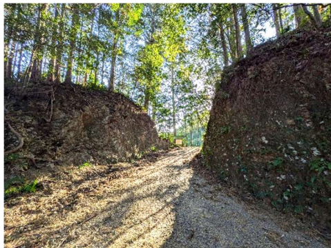
図 77 一石峠道 明治道切り通し
