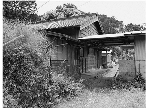
図 146 江戸屋跡の建物(解体)と熊野道
