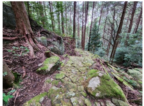
図 117 観音道 岩盤を削平した路面と石畳
