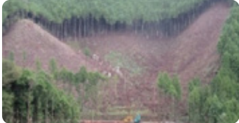
伐採・搬出後の事業地
