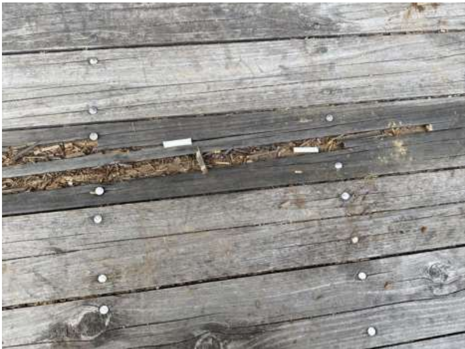
現場状況写真
