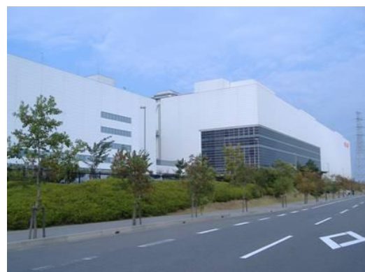
開発地における緑地整備の様子
