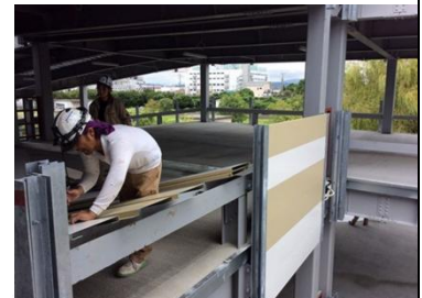
駐車場の角部の施工風景
