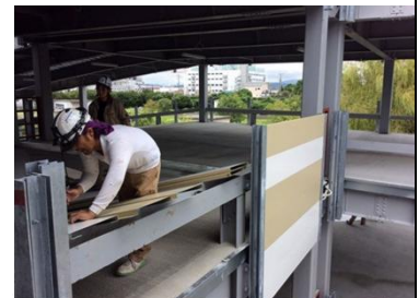
駐車場の角部の施工風景
