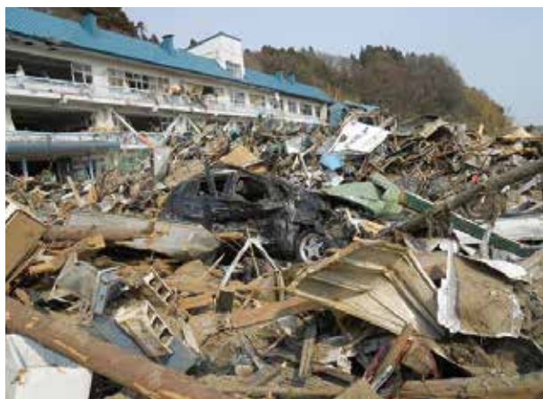
Daños producidos por el Gran Terremoto de Higashi Nihon
