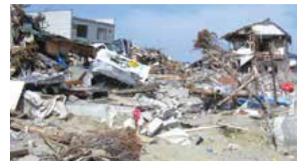
Zona de viviendas destruidas
