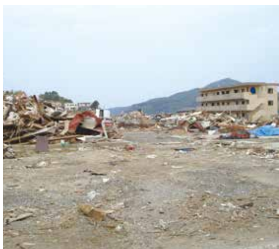
Danos do Grande Terremoto do Leste do Japão
