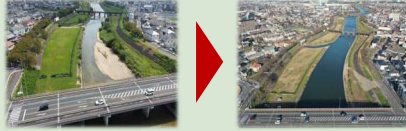
河川の堆積土砂撤去（海蔵川（四日市市））
