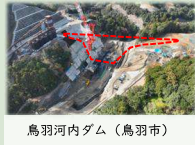
鳥羽河内ダム（鳥羽市）
