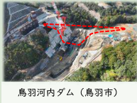
鳥羽河内ダム（鳥羽市）
