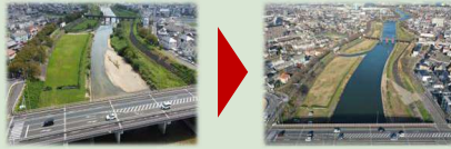
河川の堆積土砂撤去（海蔵川（四日市市））
