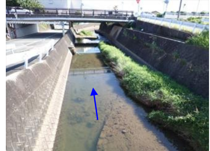
三渡川上流 (三蔵橋下流)
