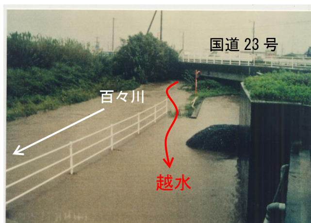
写真 2-2 平成 5 年 11 月洪水による百々川の越水状況 (国道 23 号付近 (河口より約 900m 付近) )
