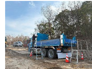
LiDARを用いた計測状況
