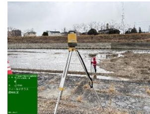
杭ナビなどの測量機器と接続
