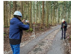
出来形管理の状況
