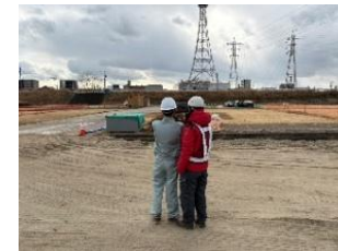
現地計測状況
