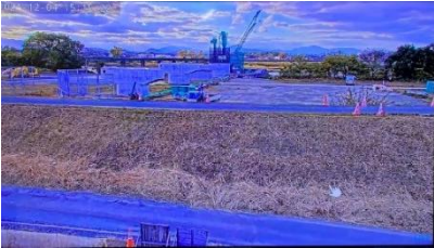
作業ヤードの監視状況
