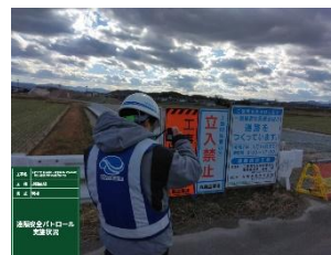
現場代理人が現地をWeb配信
