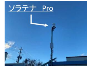
ソラテナProの設置状況
