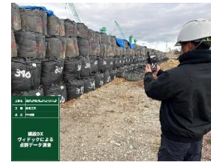
3次元データの取得（測量）状況
