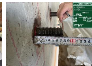
アンカー出来形撮影
