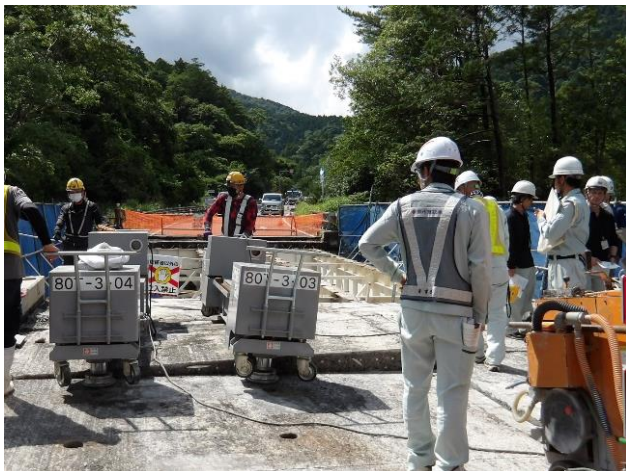
床版取り壊し状況
