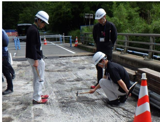
床版損傷部点検状況(打音検査)
