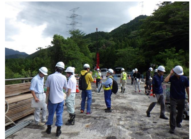
床版損傷部点検状況(目視確認)
