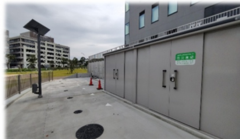
ソーラー照明 1 基・資材倉庫 1 棟
