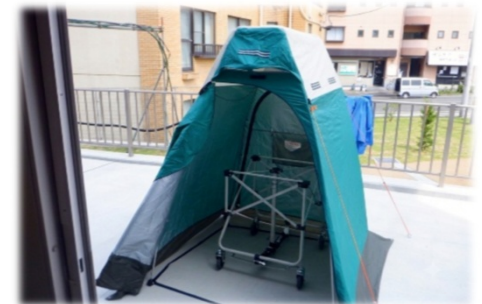
マンホールトイレ 5 基
