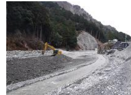
砂防堆積土砂撤去事業 (三重県)
