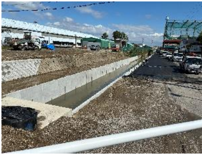
【朝日町】小向雨水幹線整備事業
