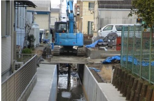
【川越町】下水道(雨水)施設整備事業
