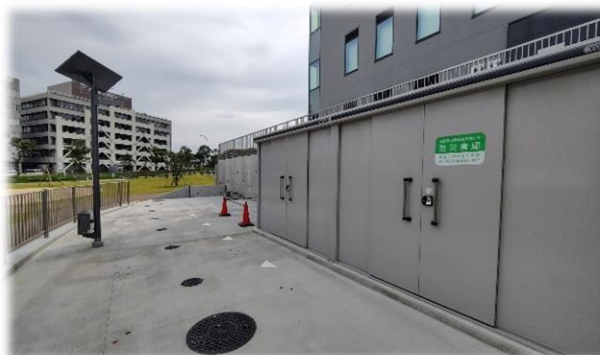
ソーラー照明 1 基・資材倉庫 1 棟
