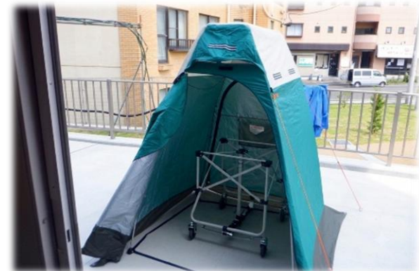
マンホールトイレ 5 基
