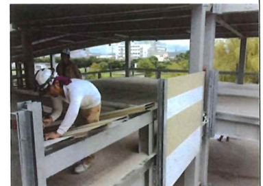
駐車場の角部の施工風景
