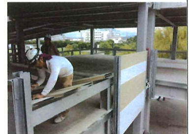
駐車場の角部の施工風景
