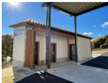
四日市農芸高等学校（屋外トイレ） （木造）
