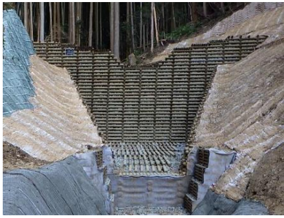
本体工（ダム構造部材）
