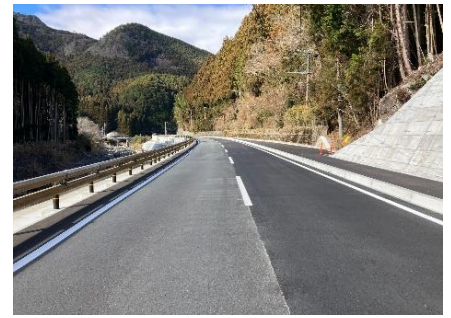
木製ガードレール
