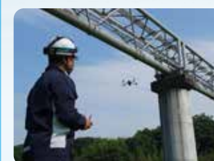
ドローンによる点検
