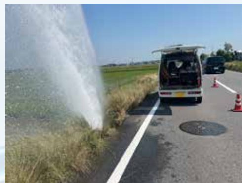
老朽化による水道管の破損
