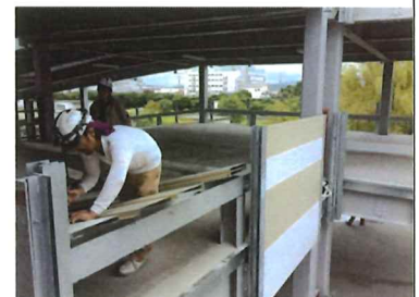
駐車場の角部の施工風景
