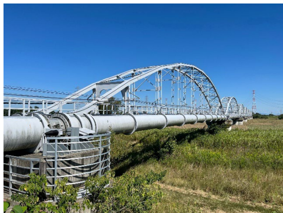
揖斐川水管橋（桑名市）
