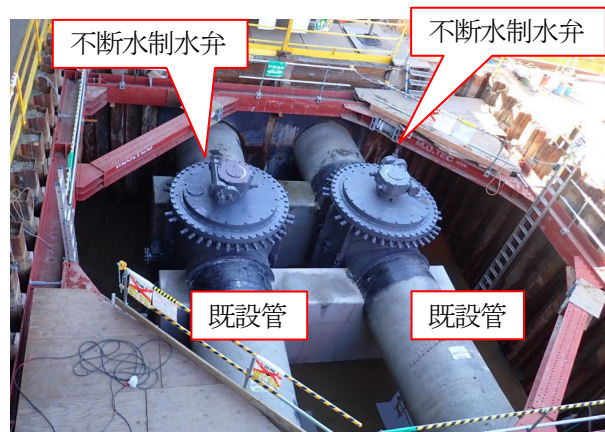
不斷水工法による制水弁取替工事の施工状況 （桑名市）
