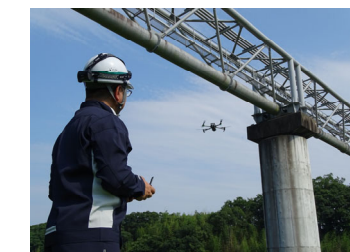
ドローンによる施設点検
