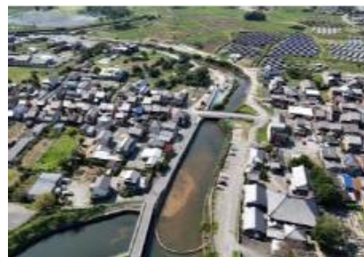
護岸改修事業
