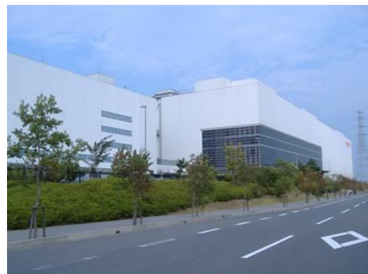
開発地における緑地整備の様子
