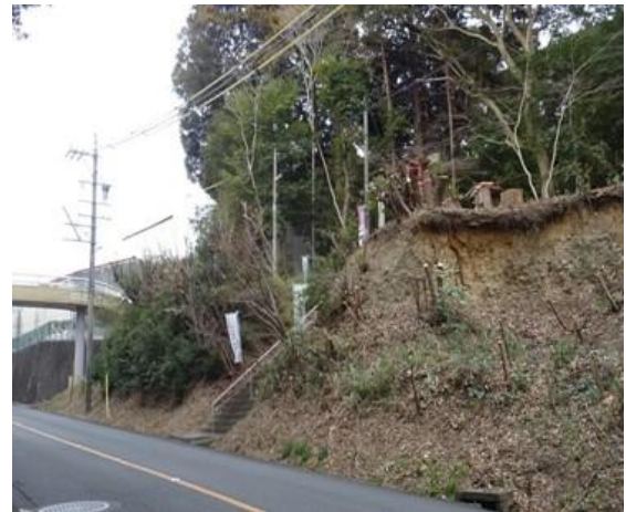
電線近くの危険木の事前伐採（鈴鹿市）
